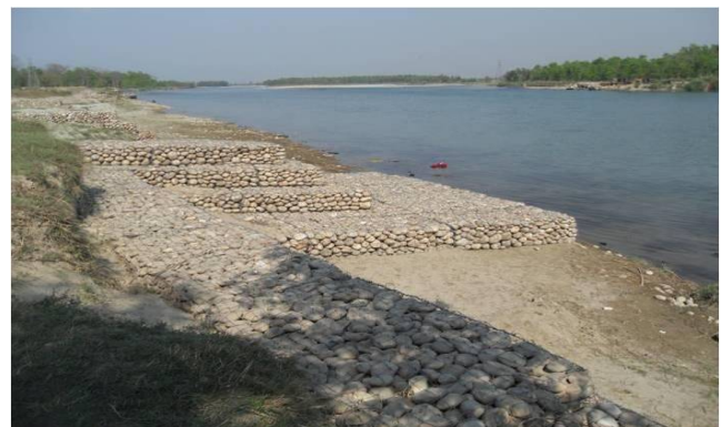
Figure 12: Revetment with falling apron (Karnali River)
